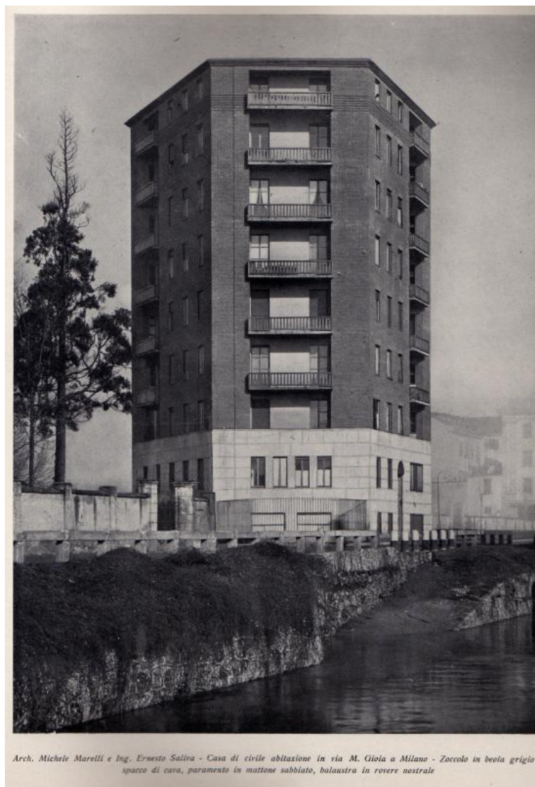
FIG. 3.2.1.39 Edificio di civile abitazione all'angolo via M. Gioia –via Algarotti (1936) – archh. M. Marelli, E. Saliva
