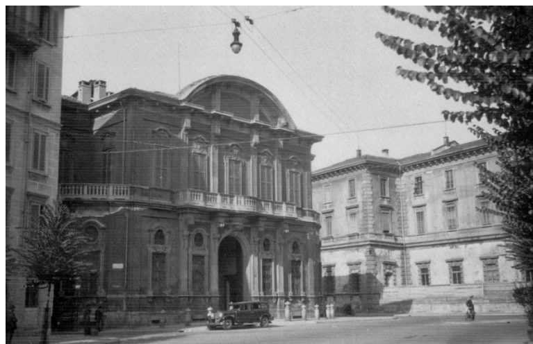
FIG. 3.2.3.2.48 Palazzo Sormani Andreani Verri e il Naviglio. La fotografia rende la qualità urbana dei luoghi, poco prima della copertura della Fossa Interna..
