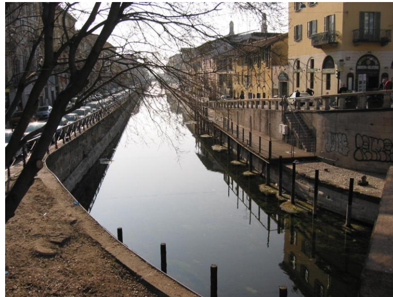
FIG. 2.1.2.1.4 Il Naviglio Grande al ponte dello scodellino prima dell'ingresso in Darsena
